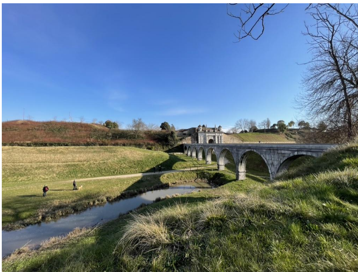
In foto l'acquedotto e porta Udine sullo sfondo.
